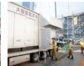
大容量電源車による給電訓練
