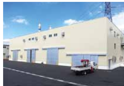
防災資機材専用倉庫の設置
