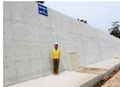
防潮堤の構築
