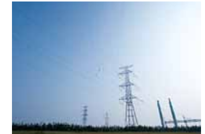
送電線(志賀中能登線・志賀原子力線・赤住線)
