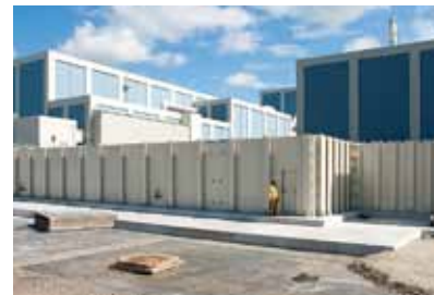
取水槽及び放水槽廻りへの防潮壁の設置
