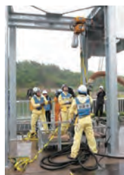
大坪川ダムからの取水訓練
