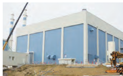
建設中の緊急時対策棟
